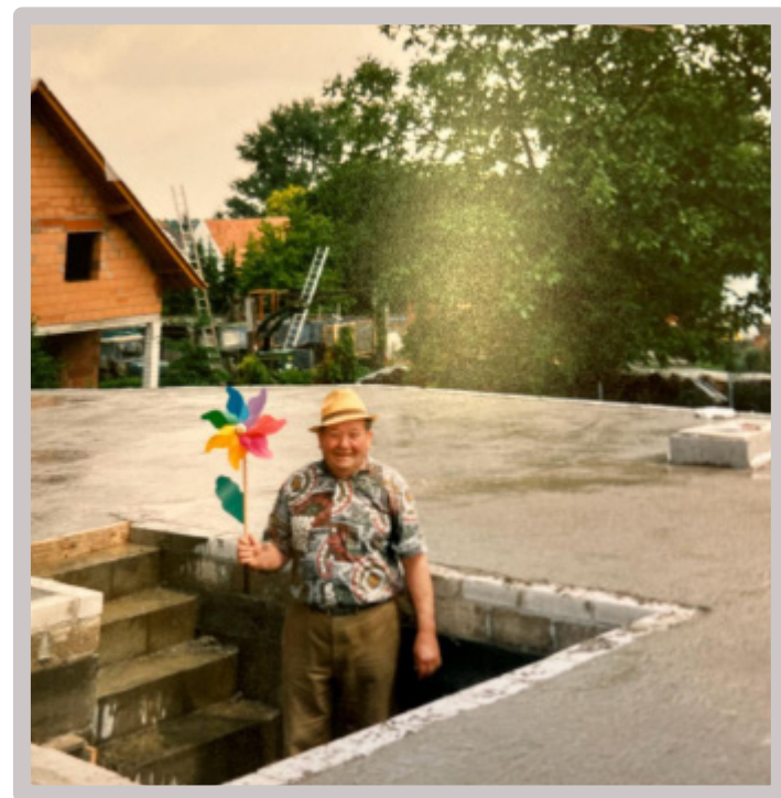
Brachte schon vor Jahren frischen Wind an die Oppenheimer Straße: Der Vater von Judith Mendel, Kurt Feldmann, während der Bauarbeiten zum Aufstocken des Gebäudes. (Foto:privat)
